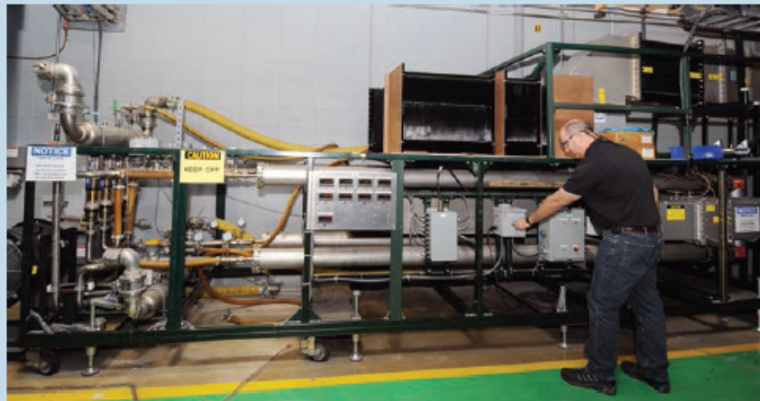
1-MW rf load
